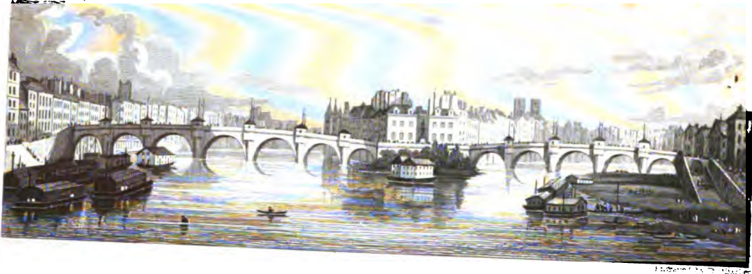
PONT NEUF, FROM PONT DES ARTS.
